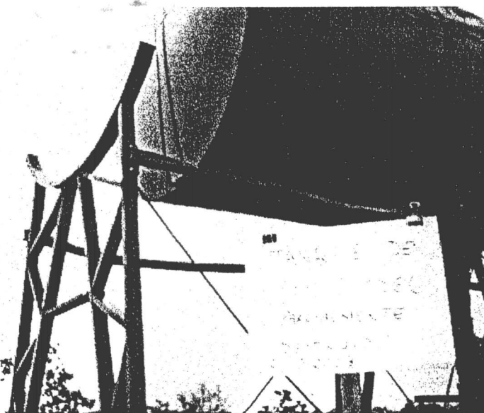
foto nº.032 – Deslocamento do tanque de sua base de sustentação.
